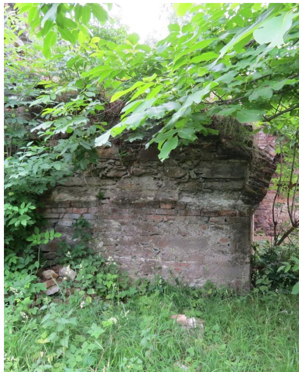
A nyugati és az északi pince csatlakozása
